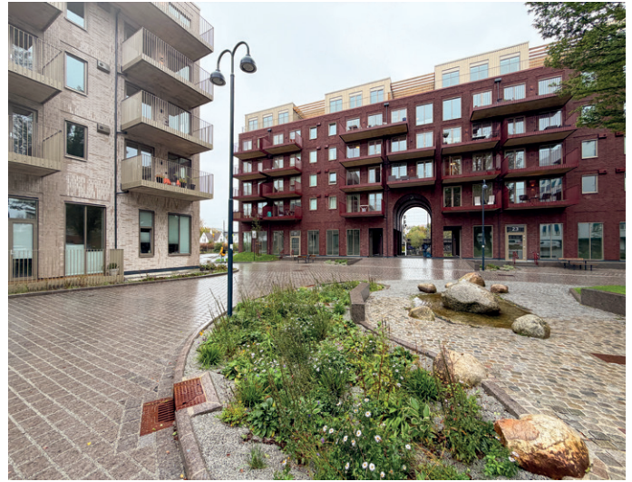
Et av de mest iøynefallende grepene i prosjektet er den buede portalen.
