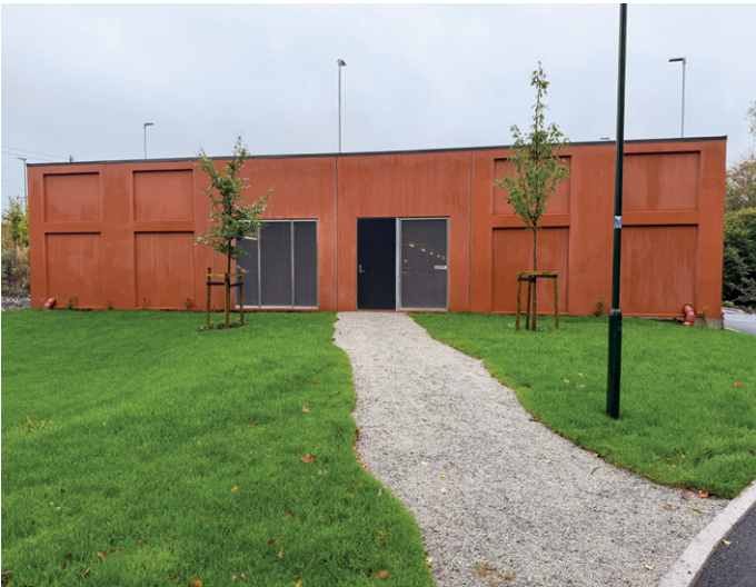
Parkeringsanlegget er satt opp like ved blokkene.
